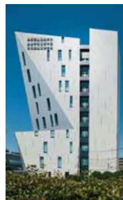
2018年4月竣工の新校舎
