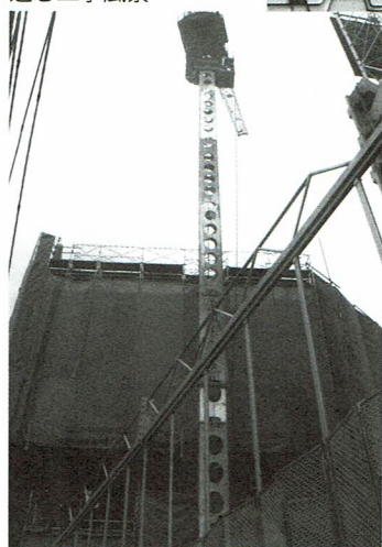
進む工事風景
