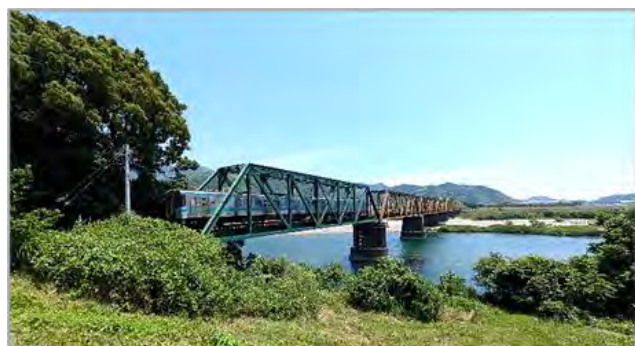
土讃線仁淀川橋梁
